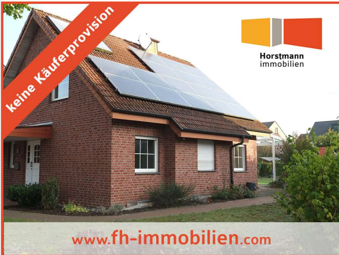
Haus mit Solar + Photovoltaik
